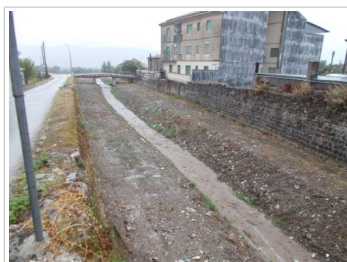
Canale Fabbriato – Lavori di Ricavamento e Riprofilatura sezione idrica.
