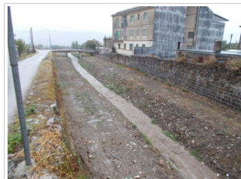
Canale Fabbriaco – Lavori di Ricavamento e Riprofilatura sezione idrica.
